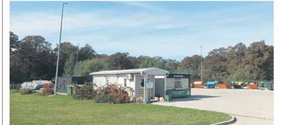
Reciklažno dvorište Ilovac i otkup ambalažnog otpada (Zagrebačka 17d)
